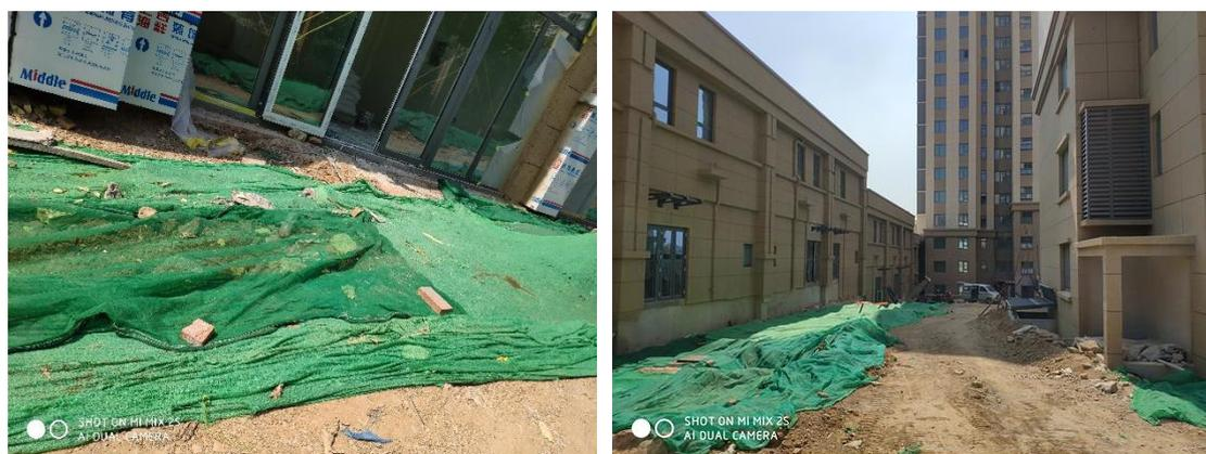
图 5-1 项目施工期采取的防尘措施
