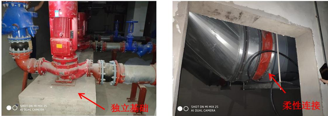
图 6-1 项目采取的隔声降噪措施
